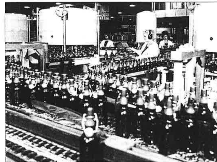
Bij het aseptisch verpakken loopt door de overdruk die ontstaat, schuim over de flessen. Hierdoor kan geen nabesmetting in de fles plaatsvinden.
