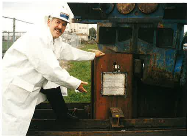
Gedeputeerde Oosterhof laat de laatste damwand zakken.
