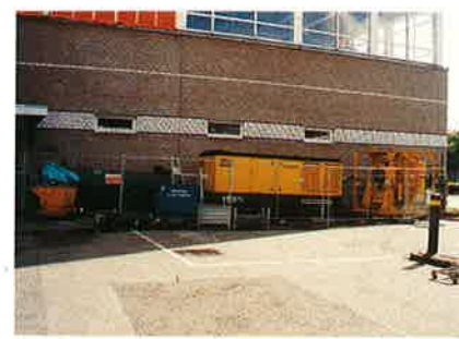
Een mobiele com- pressor werd geïn- stalleerd (vlak naast het brouwhuis).
