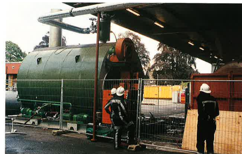
Om colonne 9 weer in productie te nemen werd een stoomketel tijdelijk opgesteld onder het afdak. Onze bedrijfsbrandweer begeleidde het installeren.
