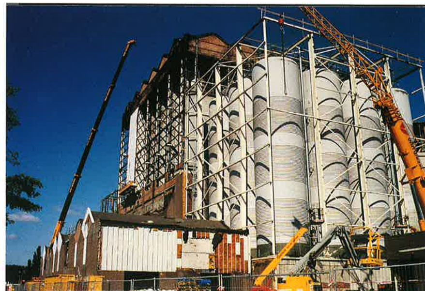
Nu de ontmanteling van kelder 4 en 5 voltooid is, is men inmiddels begonnen om de omkleiding van beide kelders in oorspronkelijke staat terug te brengen.
