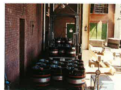
Door enorme inzet en doorzettingsvermogen konden 5 weken na de ramp de eerste bier- fusten via een herstelde liftinstallatie naar boven, richting vatentapperij.
