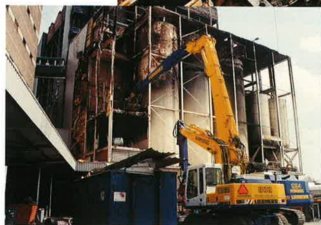
De verwoeste afval- waterzuiverings- installatie werd geheel ontdaan van beplating en opbouwconstructie. De bovenstukken van de grote ketels werden daarna afge- zaagd.
