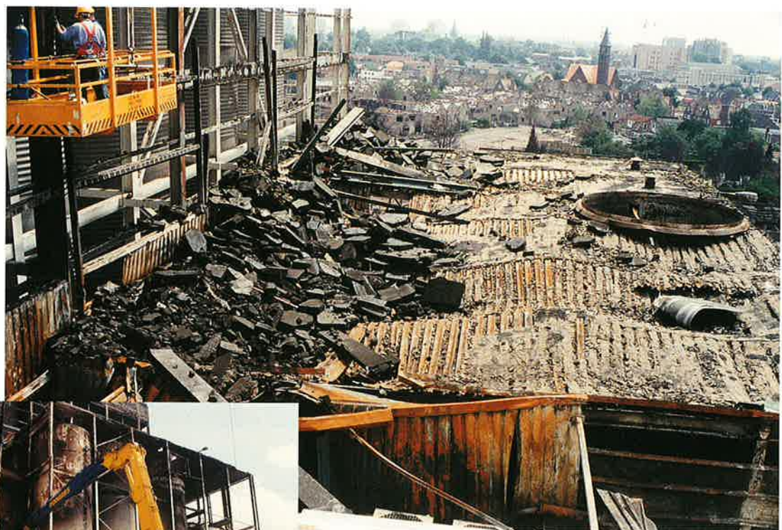
De verwoeste afval- waterzuiverings- installatie werd geheel ontdaan van beplating en opbouwconstructie. De bovenstukken van de grote ketels werden daarna afge- zaagd.
