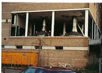
Ook het brouwhuis liep vooral een enorme glas- schade op. Alle ramen werden ontzet en moesten worden vervangen. Het glas verdween in grote containers.
